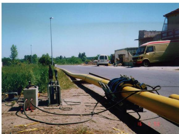
Izgradnja i zavarivanje polietilenskih plinovoda
